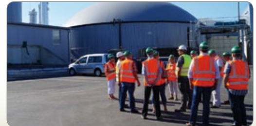
Informationen vor Ort: Besichtigung der Nawaro-Biogasanlage in Berghem-Paffendorf
